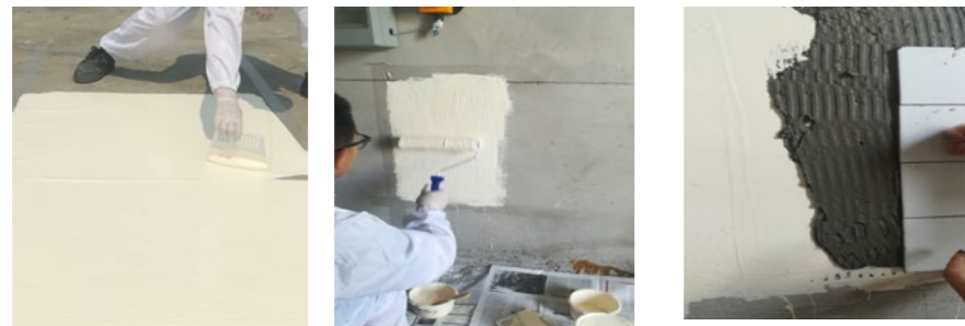
图5 部分施工现场（左：刮涂；中：辊涂；右：立面涂料上铺贴瓷砖）
