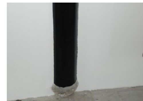
图 4 重要建筑物防水 A3 工法
