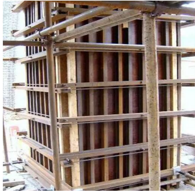
对于截面较大的矩形截面混凝土柱，其抱箍可采用型钢，型钢型号和间距通过计算后确定。
