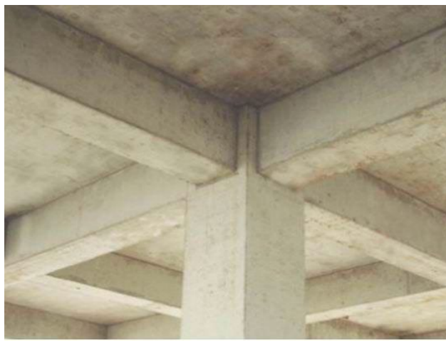
混凝土柱、梁、板线条顺直，棱角方正，色泽一致
