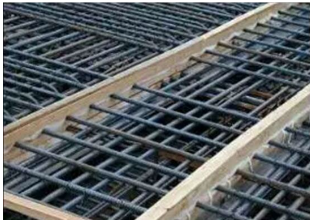
后浇带钢筋绑扎
